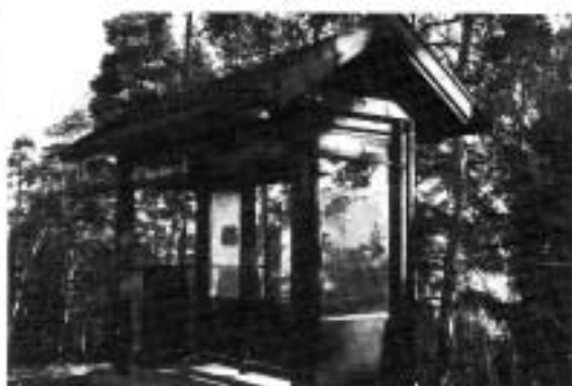
Det nye stoppestedet ved Nedre Movei
