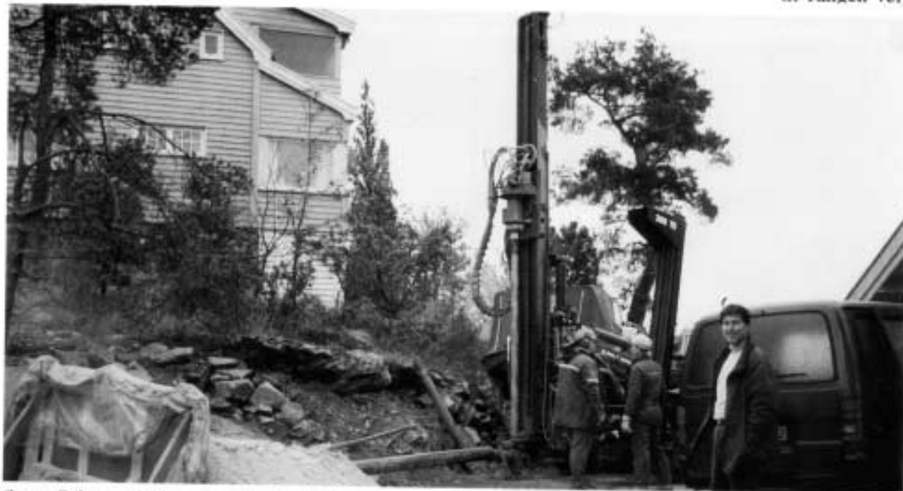
Gunnar Eriksson ved siden av boreriggen hos Helge Lem i Gråbeinberget. 100 m ned måtte bores, men da ble det vann nok!
