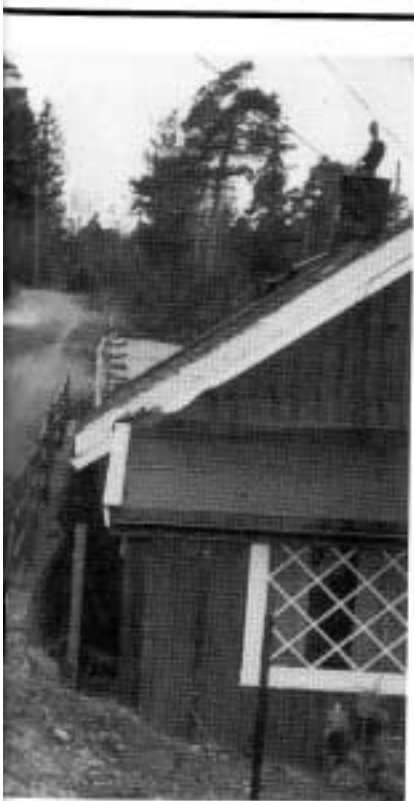
for å forhindre at Nedre Movei siger kloss inntil veien.
