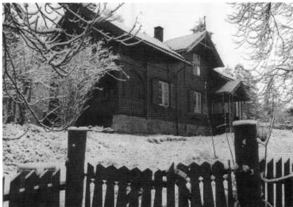
HELGOLF: De håndvermessige utsmykningene er karakteristisk for hus bygget omkring århundreskiftet. For et par år siden ble huset rehabilitert utvendig, og fikk en staselig gårdsrød farge med blått og grønt i treutsmykningene. (Foto: Knut Falch)
