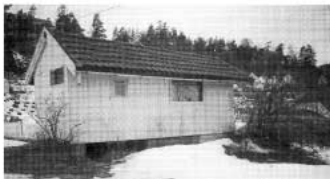
Nesoddens eldste postkontor ligger på hjørnet av Oksvalveien og Bakkegårdsveien. Ekspedisjonsluka i kortveggen til venstre.
